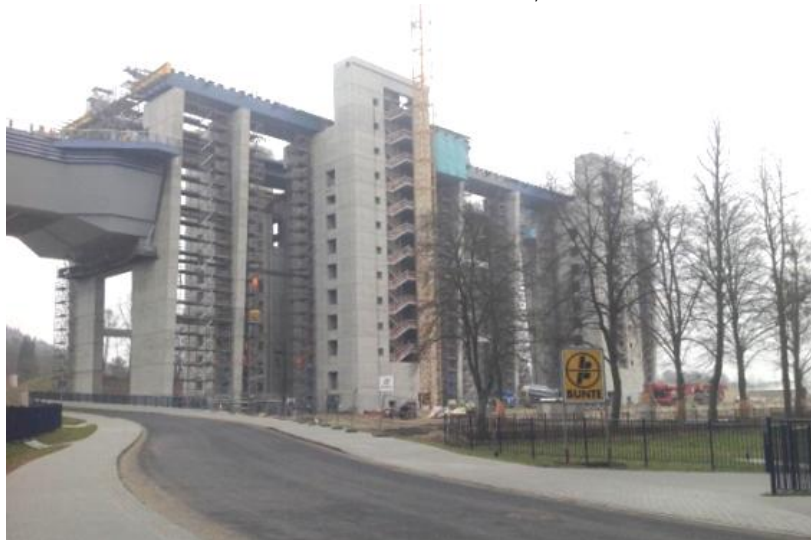
New Finow canal lift (T Hales)
